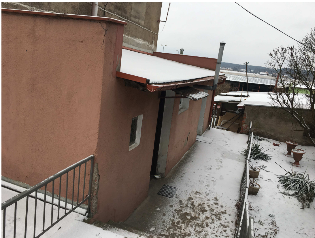
Widok dobudówki przy ścianie zachodniej
