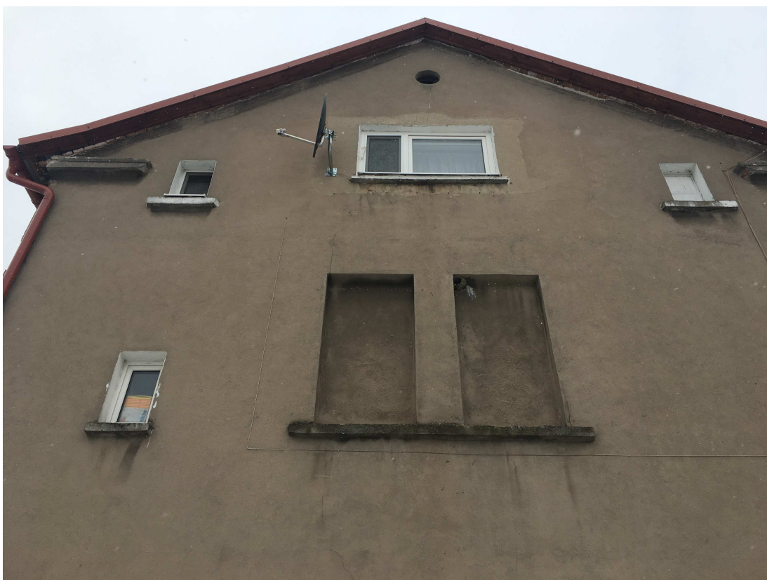
Widok detali gzymsu – ściana szczytowa
