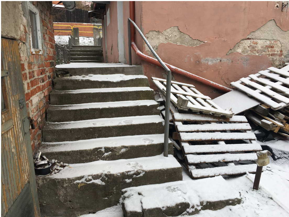
Widok schodów zewnętrznych przy dobudówce
