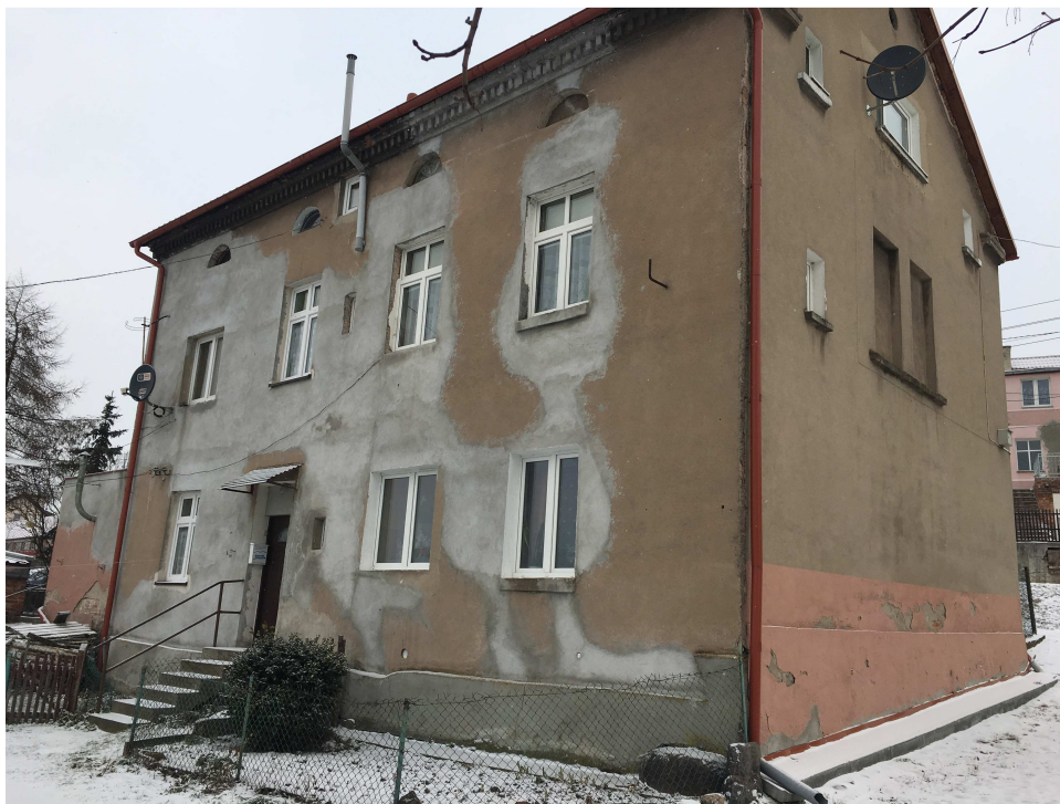
Widok elewacji budynku od strony podwórza
