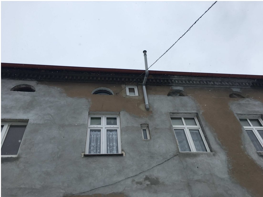
Widok detalu gzymsu wieńczącego – ściana od strony podwórza
