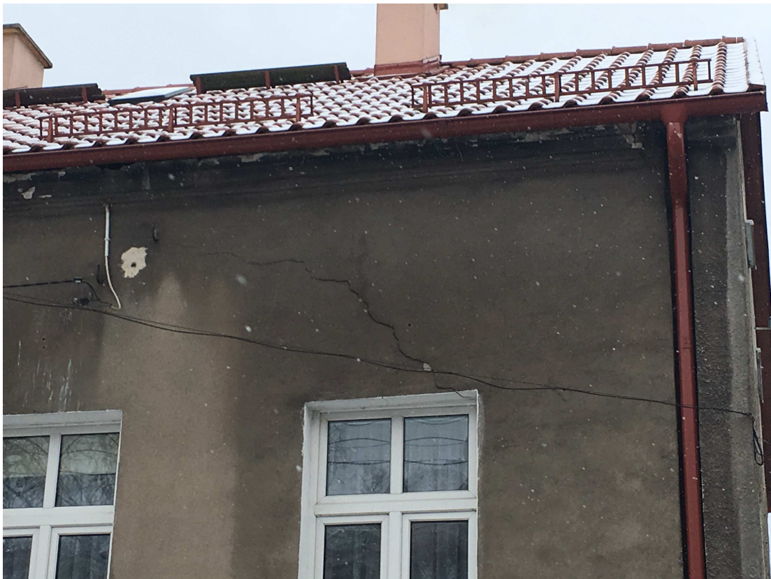
Widok pęknięcia ściany od strony ul. Wiślanej
